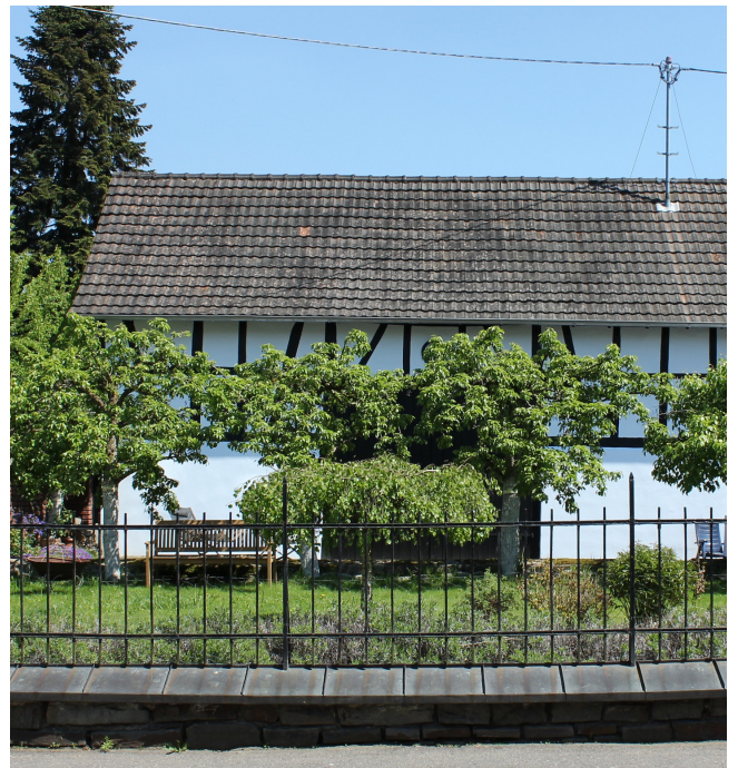
Vorzonengestaltungen und Einfriedungen in Dattenfeld
