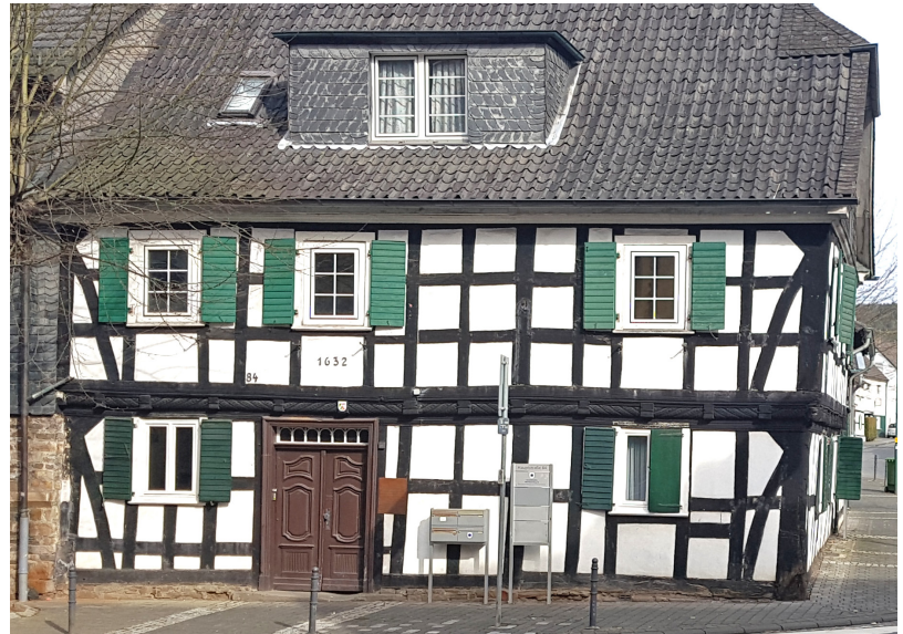
Sichtfachwerk Hauptstraße 84, Dattenfeld
