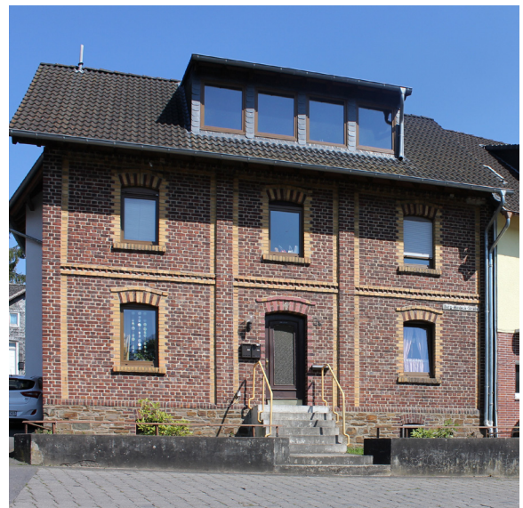
Sichtmauerwerk Burg-Windeck-Straße 2b, Schladern
