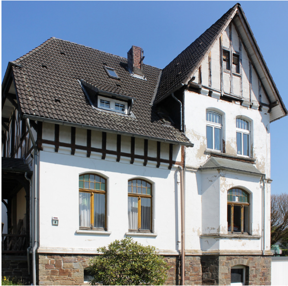
Zwerchhaus, Burg-Windeck-Straße 8, Schladerm
