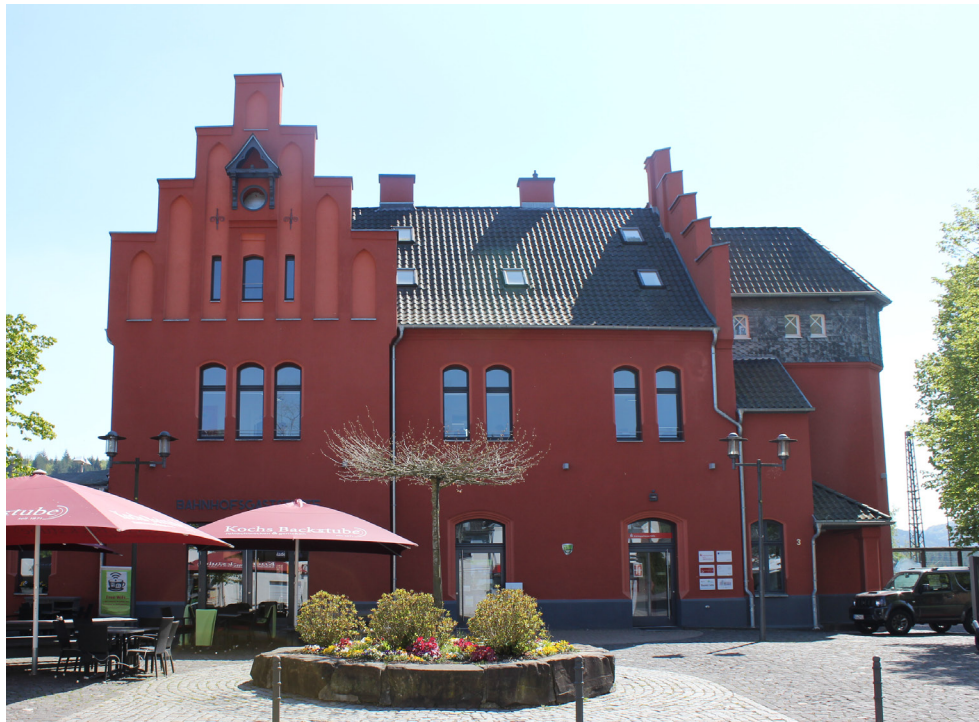
Bahnhof Schladern, Waldbröler Straße 3
