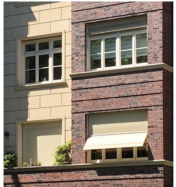
Sonnenschutz in Düsseldorf – gestalterisch integriert
