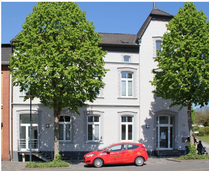
Backsteinbau, geschlämmt Waldbröler Straße 28, Schladern
